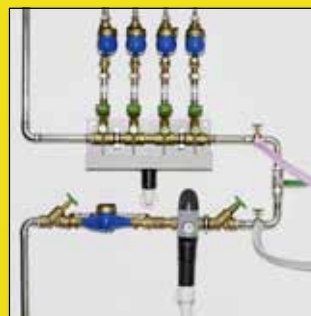
Proplachování rozvodů pitné vody (S/SL/SLW)
