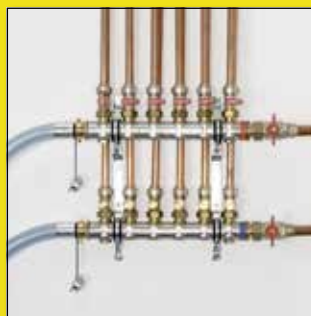
Proplachování radiátorů a plošných topných systémů (S/SL/SLW)
